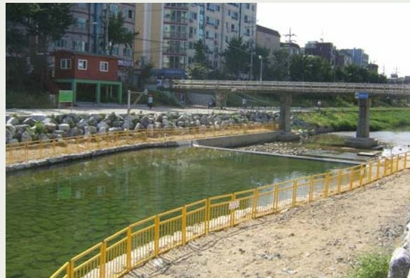
불광천변 보호 난간 시공
