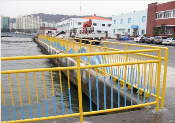
마산지방해양수산청 난간 시공
