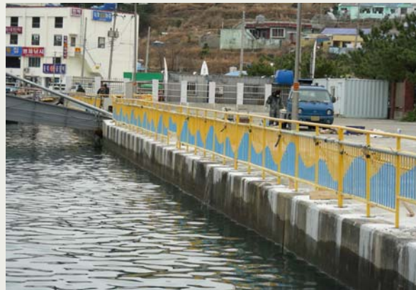
장승포여객터미널 난간 시공
